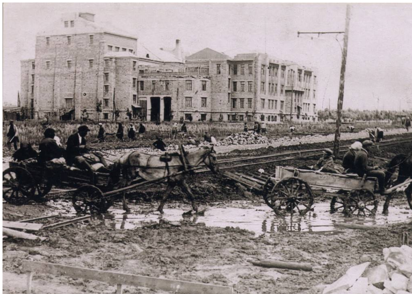
На будівництві Палацу праці. 1927 рік.
